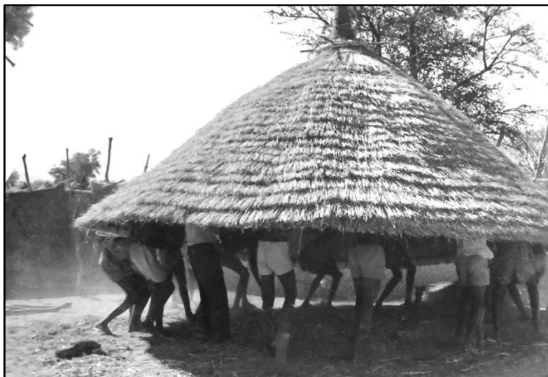
Déplacement d'un toit de case.
