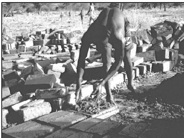
On moule les briques que l'on laisse ensuite sécher au soleil.
