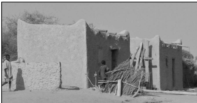
Case en terre : les murs sont montés en briques séchées puis crépis avec du poto-poto de même que son toit qui évacue l'eau de pluie par ses gargouilles en terre cuite.
