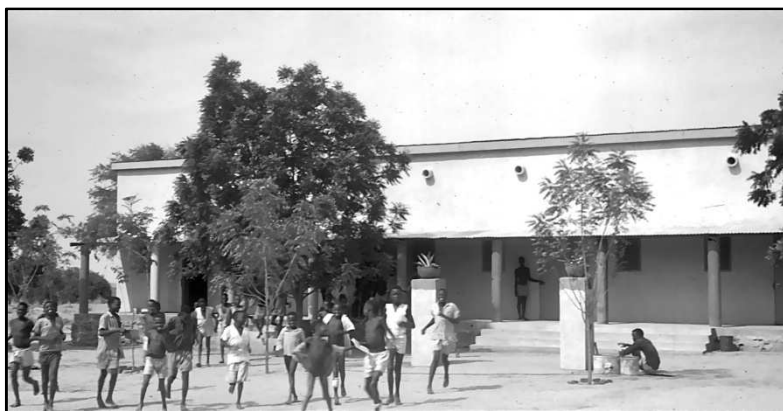
Le bâtiment de l'internat.
