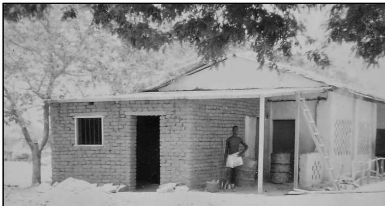
Le dispensaire a été agrandi. On voit ici l'officine accolée au bâtiment principal.
